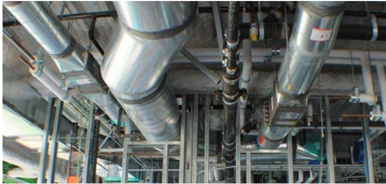
Actual drywall framing around the MEP equipment.
